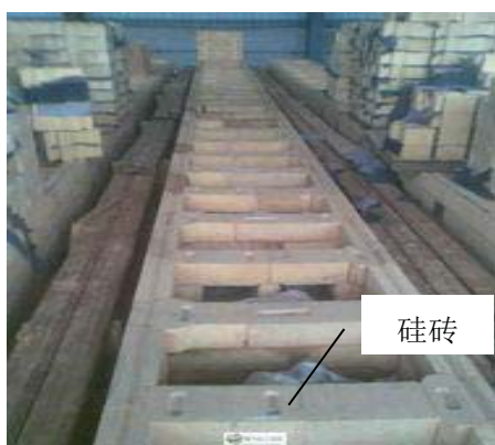
图1 采用高导热硅砖的焦炉炭化室
